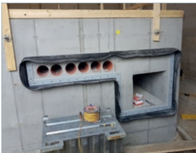
Industriebau: Anschluss Altbestand an Neubau. Klemmfugenband, Rohrdurchführungen
