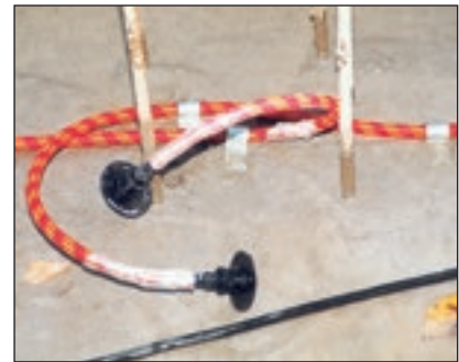
Schlauch fertig verlegt. Die Packer werden an die Schalung genagelt.
