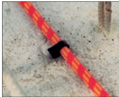
Befestigung mit Kunststoffclips, die vorher in den Frischbeton gesetzt wurden, oder ins Bohrloch \varnothing 8 mm eingeschlagen werden. Abstand 15 cm
