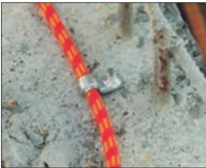
Befestigung mit Metallschellen zum Schießen oder Nageln. Abstand max. 15 cm
