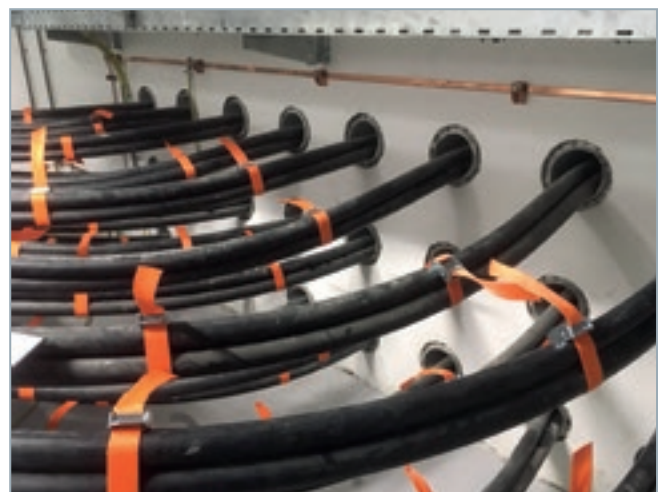
Rohrdurchführungen für Starkstromkabel
