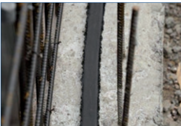
Verlegung mit Quellbandkleber
