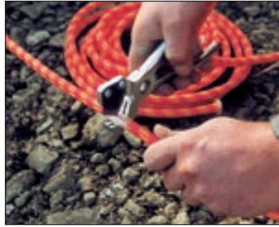
Schlauch zum Ablängen mit Filamentband abkleben (Verpresskreis max. 8 m).
