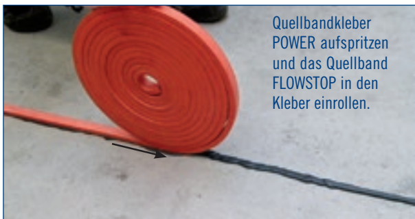
Abdichtung einer Arbeitsfuge
