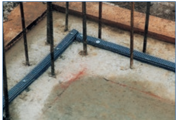
Verlegung mit Befestigungsgitter und Nägel
