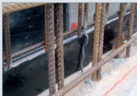
Verbindung mit Stoßklammer
