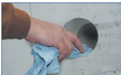
Entstauben der Kernbohrung
